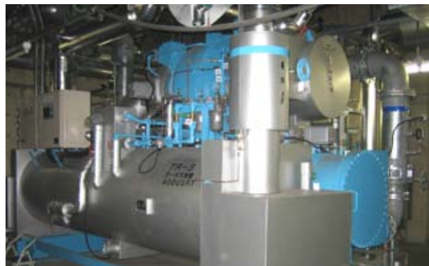
30%省エネルギーを目指した東京駅京葉線ホーム空調和設備工事
