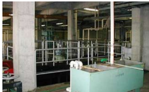
小山新幹線車両センター汚水処理装置
